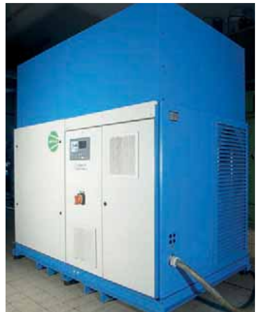
Ölfreie Druckluffertzeugung in der Brauerei: die LENTO mit 55 kW Antriebsleistung als luftgekühlte Anlage.
